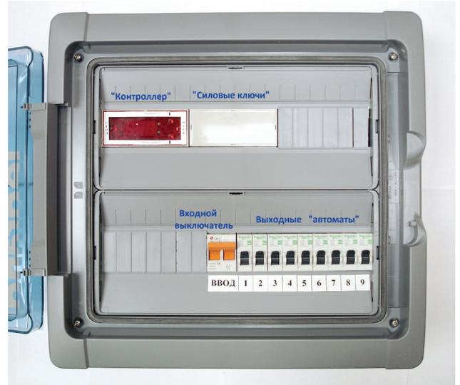
Внешний вид силового блока «Электронного звоняра»
